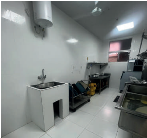
Remodelaciones en área de lavado de cocina
