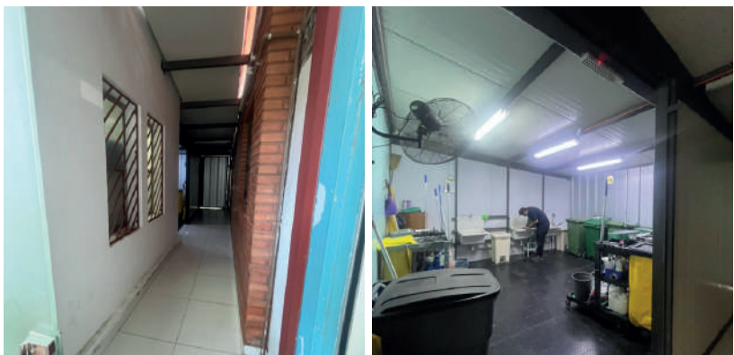
Nueva área de limpieza
