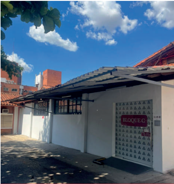
Techo a nuevo acceso de bloque c
