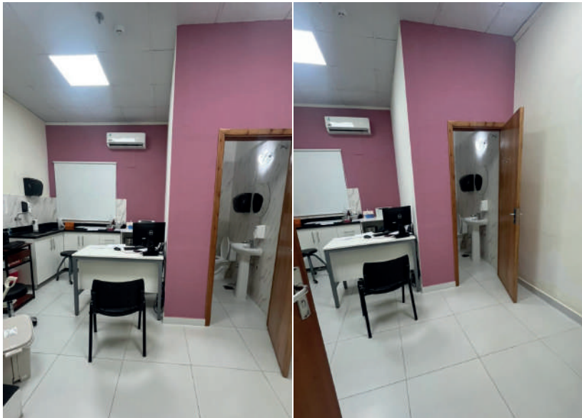
Remodelaciones en consultorio 8 Bloque A
