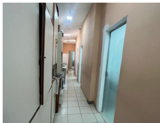
Refacciones generales en pasillo trasero de enfermería Bloque A
