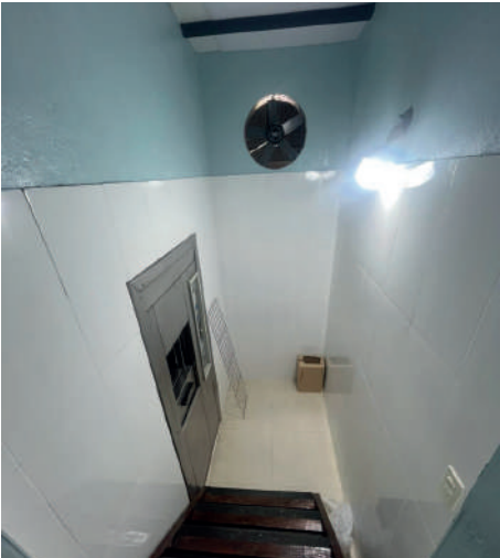
Readecuación en esterilización para autoclave
