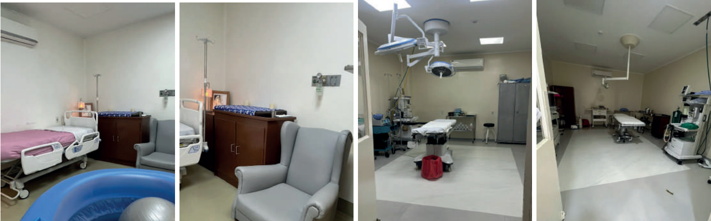
Plomería en obstetricia/mejoras
