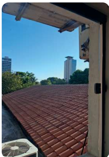
Cambio de tejado Bloque A consultorios
