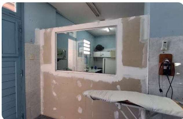
Actualización de área de descanso de lavandería
