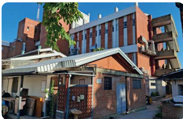
Doble techo de chapa en cocina
