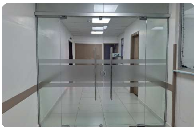
Remodelación del área de obstetricia – blindex
