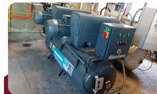
Central dúplex bomba de vacío a paleta con vsd
